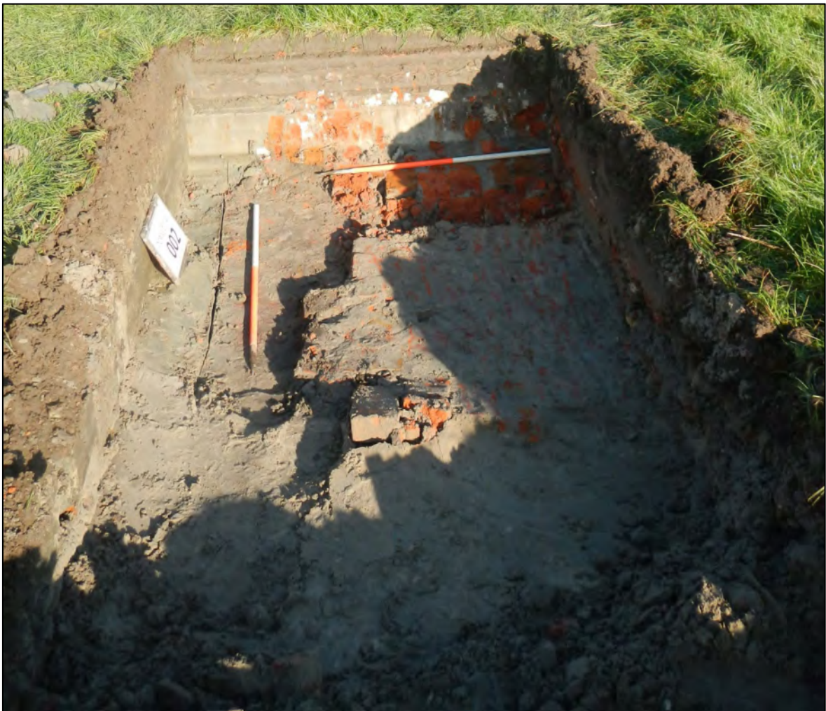
Afbeelding 5 Foto van één van de kuilen gegraven ten behoeve van het explosievenonderzoek. Op deze foto is te zien dat ook op deze locatie de fundering deels intact is bewaard. Foto genomen in zuidelijke richting.
