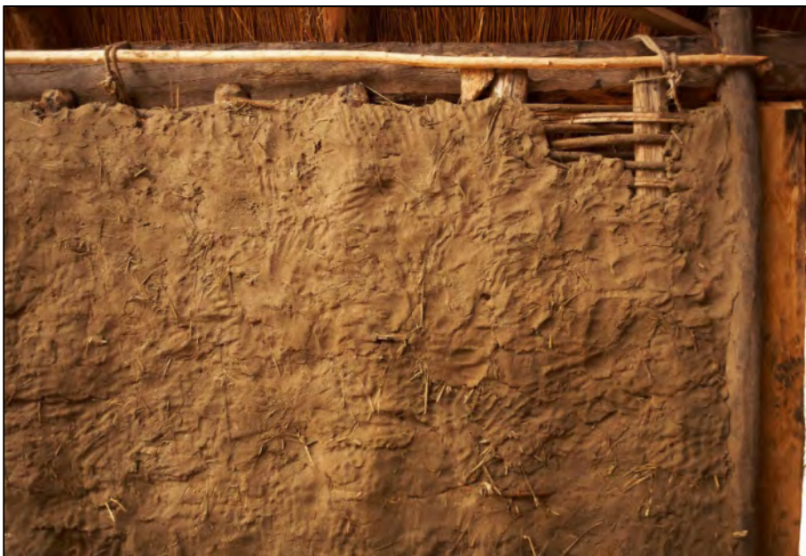
Afbeelding 15 Afbeelding van een wand opgebouwd uit vlechtwerk en bezet met hutteleem. Bron: www.exsitu.be
