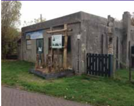
de bestaande bunker
